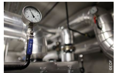
Dalkia, 1 er mise en service du réseau de chaleur Grand Arenas à Nice en novembre 2023.
