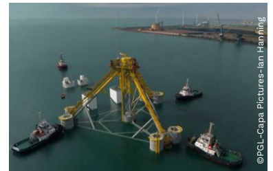
Provence Grand Large, mise à l'eau des flotteurs à Port-Saint-Louis-du-Rhône.
